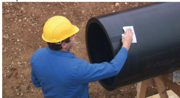
Obrázek A.21: Čištění trubky
