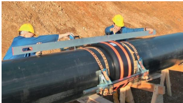
Obrázek A. 22: Montáž upínání a zaměření trubky
