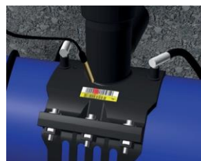
Obrázek A.39: Zadání svařovacích parametrů
