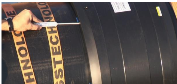
Obrázek A.26: Kontrola kruhové spáry spároměrem
