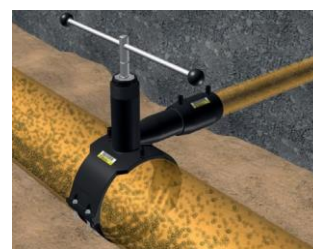
Obrázek A.36: Navrtání potrubí
