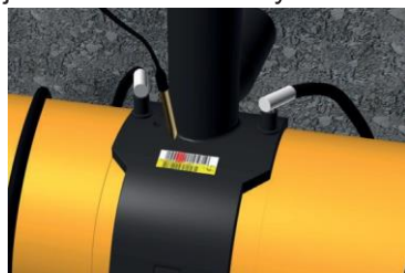
Obrázek A.35: Zadání svařovacích parametrů
