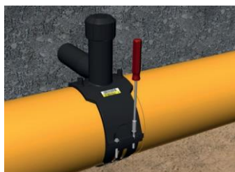
Obrázek A.34: Montáž navrtávací objímky
